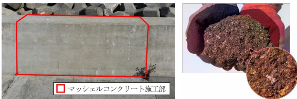
写真 5-1 ホタテ貝殻を混ぜた ㊦コンクリート（マッシュェルコンクリート）、㊦堆肥
