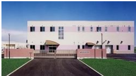
写真 2-7 森町リサイクルプラザ
