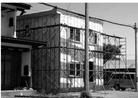
町内の住宅新築現場
