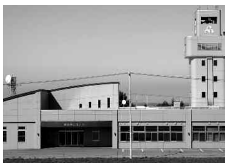
災害時の物資を備蓄している防災センター
