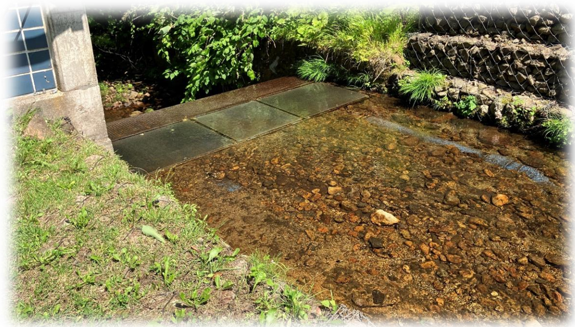
駒ヶ岳・赤井川地区 取水場
