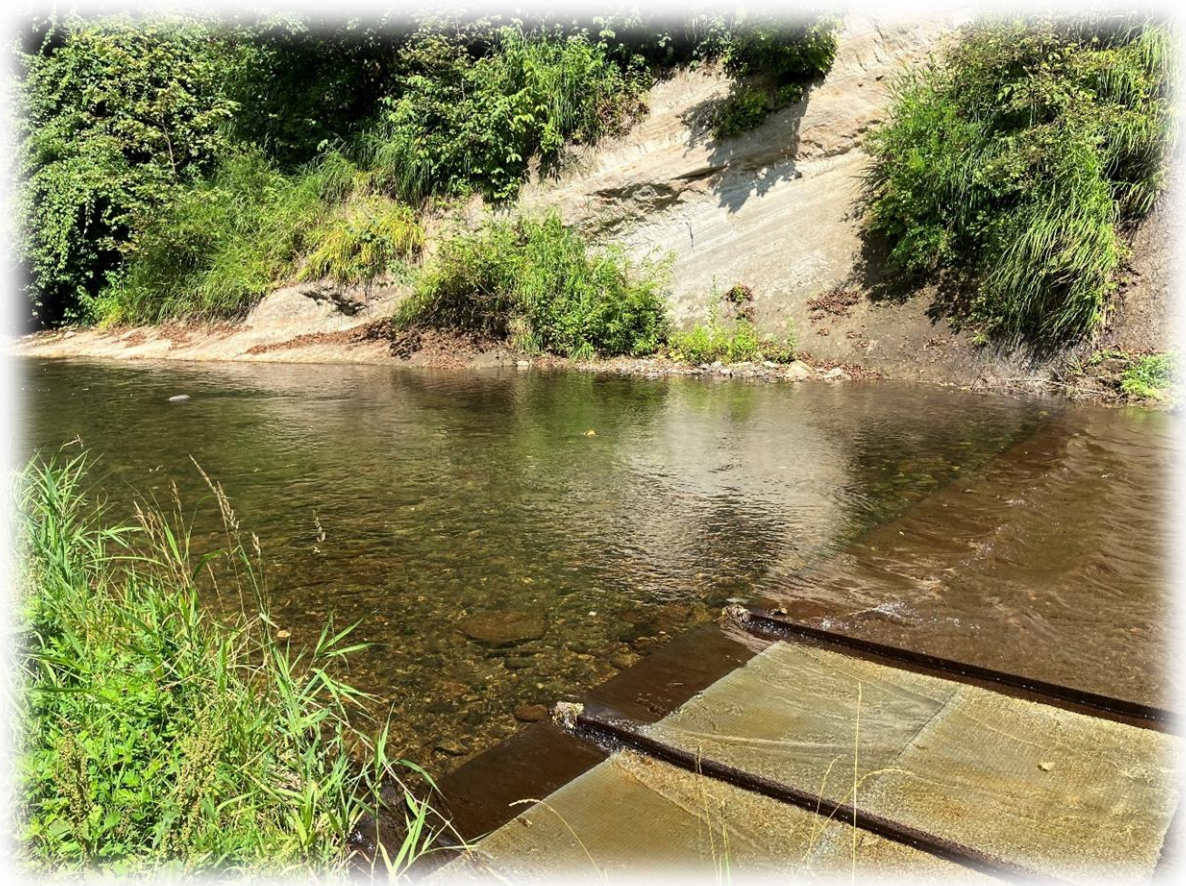
森町本町地区 取水場
