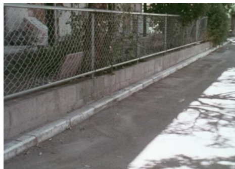
(下水道整備後)
