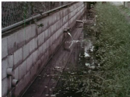
(下水道整備前)
