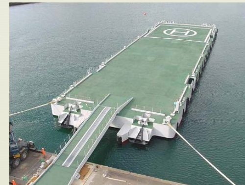
室蘭港浮体式防災施設(船長80.0m、吃水0.7m)
