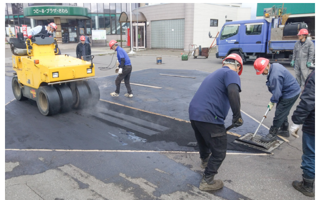
重機と手作業で駐車場を補修する作業員たち
