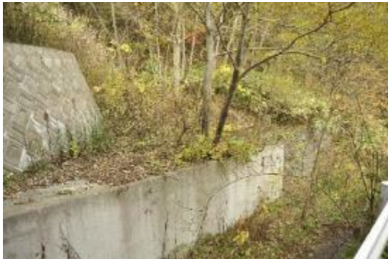
第 44 図 河川構造物（南西から）
