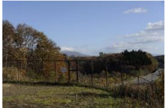
第 55 図 環状列石南東側立入防止柵（北西から）
