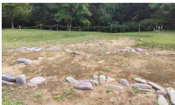
第 61 図 改良土による被覆（史跡小牧野遺跡）
