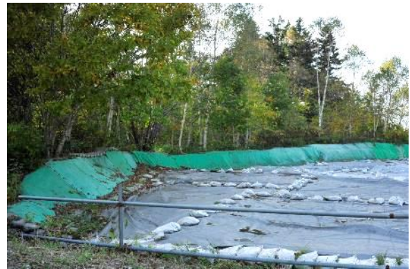
第 69 図 環状列石西側段差保持状況
