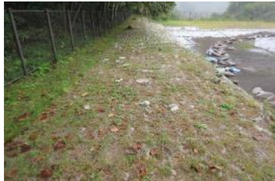
第 45 図 環状列石東側立入防止柵（北西から）
