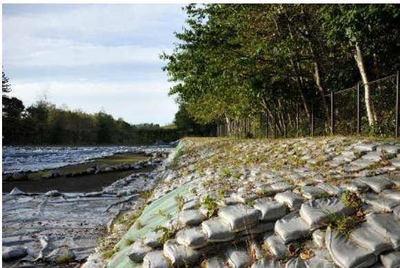
第 68 図 環状列石東側段差保持状況
