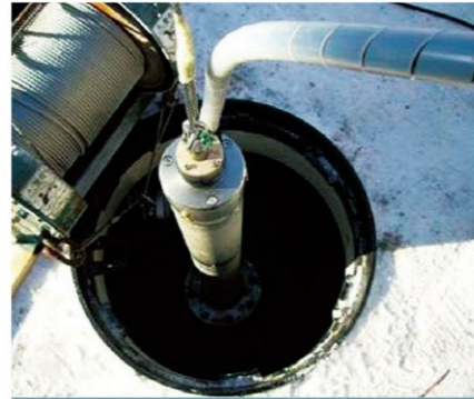
地震計・傾斜計(地下埋設ボアホール型)
